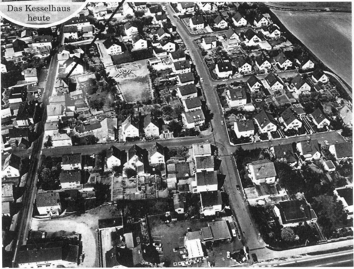
Auf dem Platz, wo die Dreschhalle stand, wurde 1935 von Fam. Schneider an der Ostendstraße ein Wohnhaus gebaut. Der vordere Teil der Dreschhalle wurde abgerissen, der hintere Teil, das Kesselhaus, steht heute noch.
